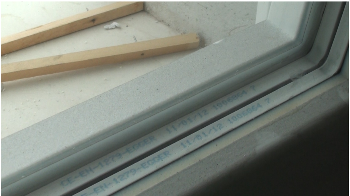
Detalle del triple acristalamiento de doble cámara con gas aislante Kriptón
