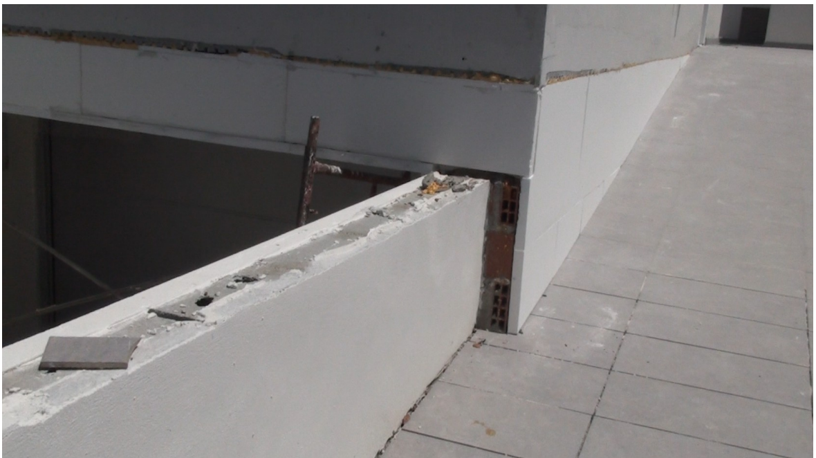
Planchas de aislamiento en frentes de forjado y laterales no cubiertos por terreno en sótano
