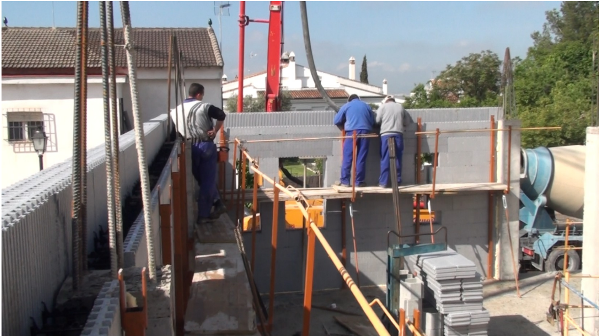
Jornada 3 – 25/04/2011 – Rellenado del muro hasta su altura completa
