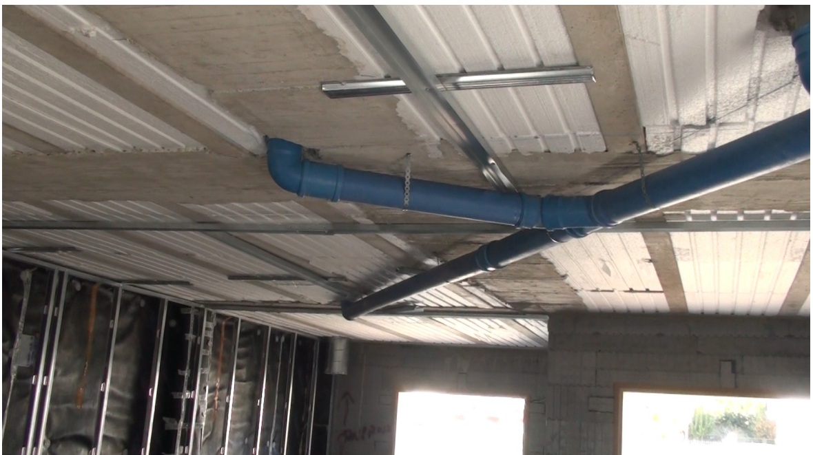
Bobedillas aislantes en techo de últimas plantas
