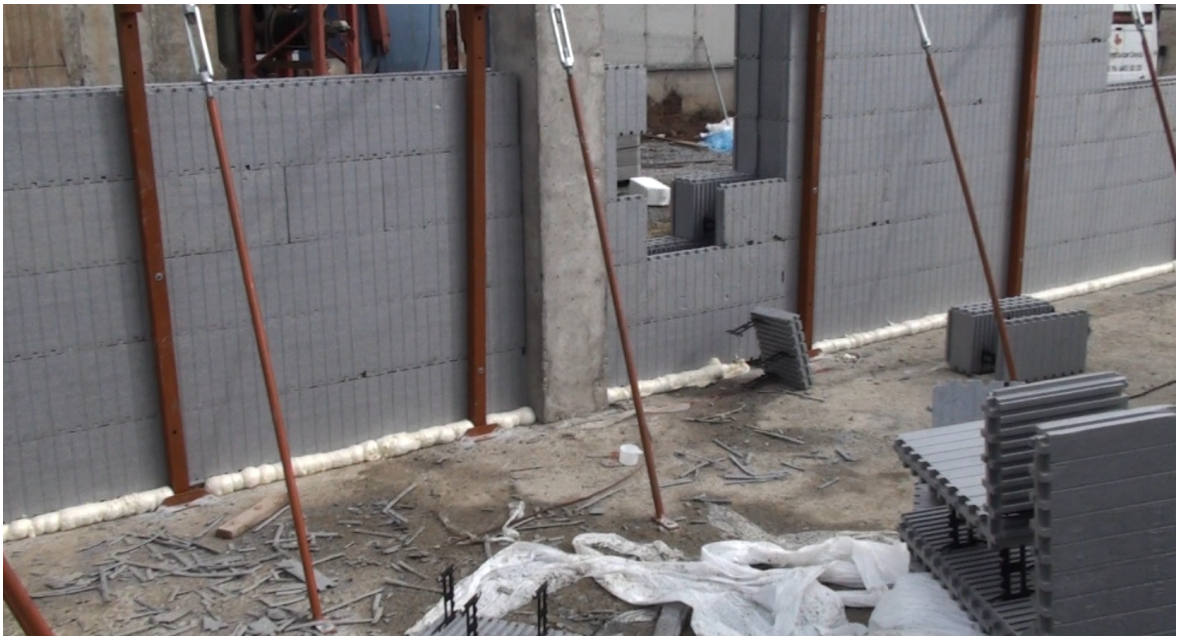
Jornada 1 – 19/04/2011 – Sellado inferior con poliuretano y continuación del muro
