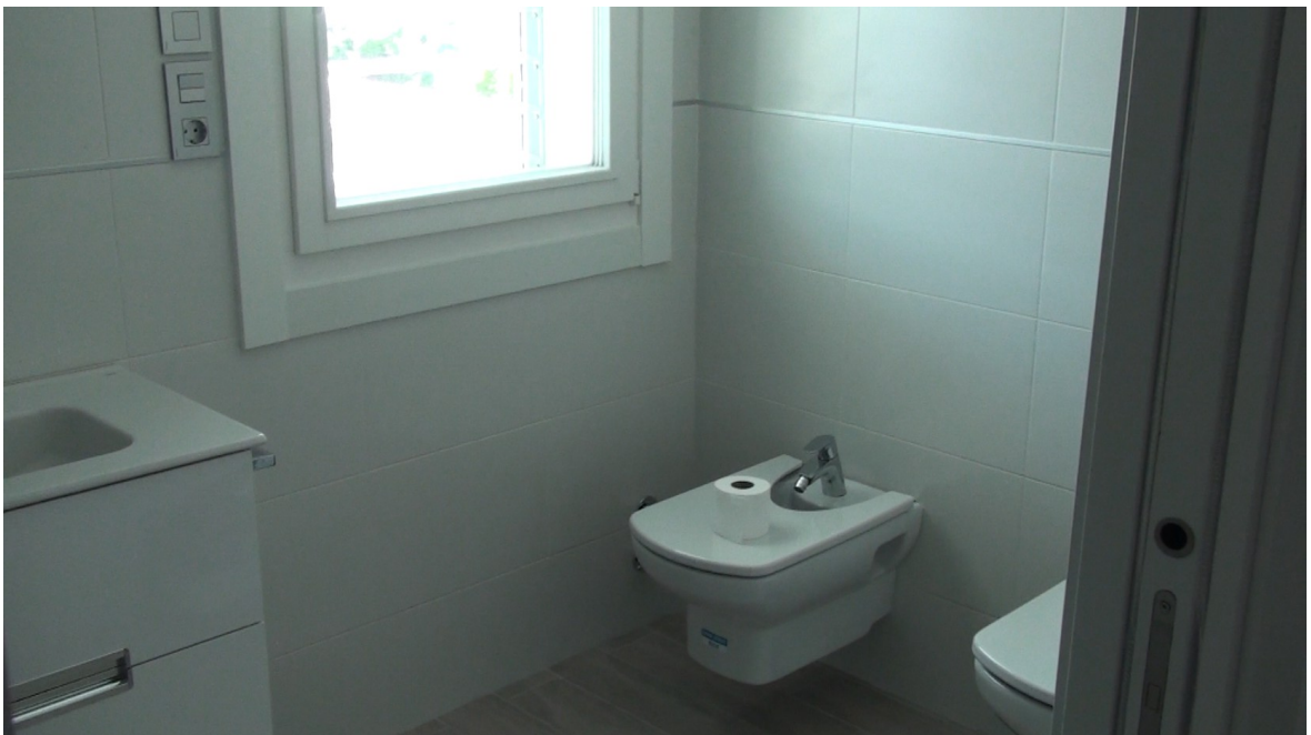
Sanitarios instalados en el mismo baño de la foto anterior
