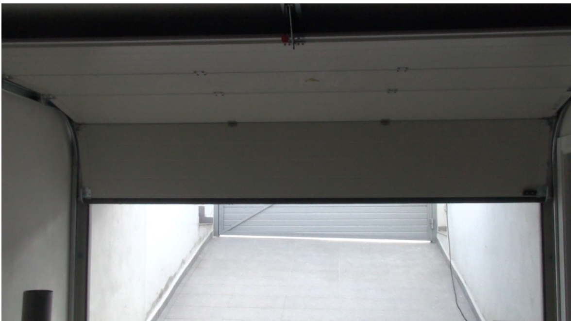
Puerta seccional Hörman LPU40 con panel sandwich de 42mm aislado con poliuretano
