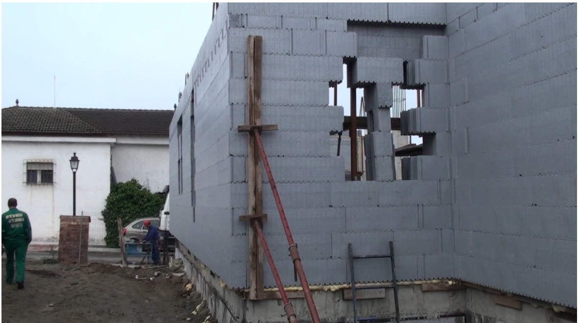
Jornada 2 – 20/04/2011 – Se finaliza el muro en su altura completa con ayuda de Styrostone
