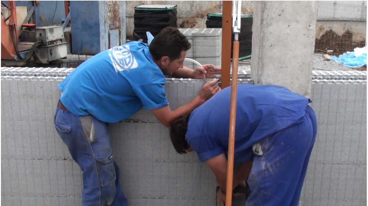
Jornada 1 – 19/04/2011 – Instalación de andamiaje interior de aplomado por Estructuristas
