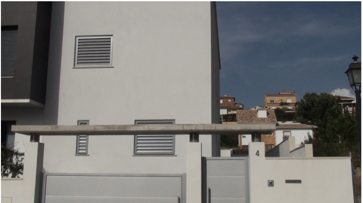
Detalle de fachada frontal a calle terminada
