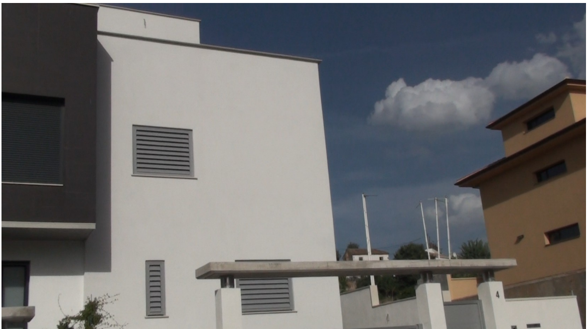
Vista de la fachada con el revestimiento terminado
