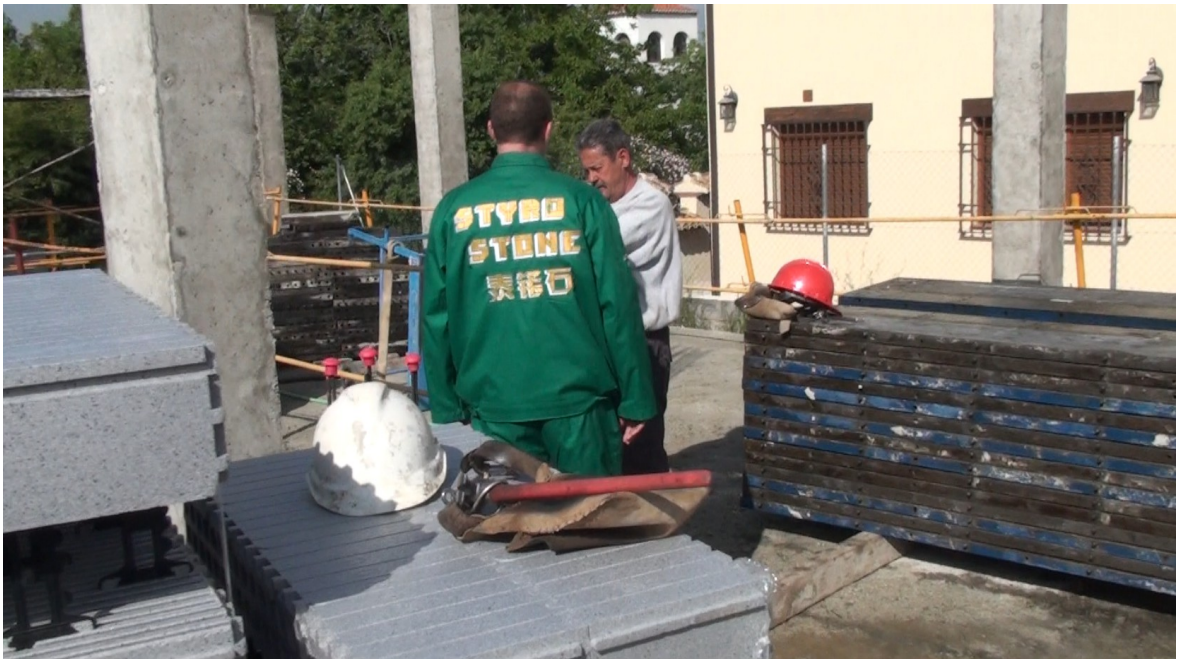
Jornada 1 – 19/04/2011 – Instrucción en Obra
