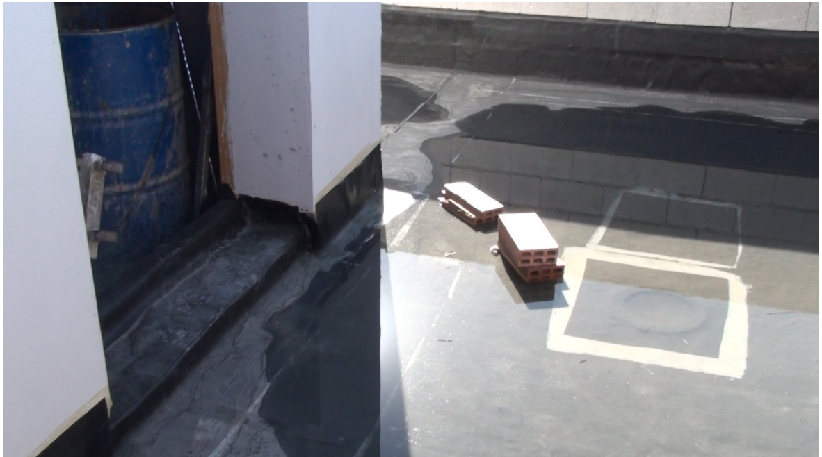
Impermeabilización con EPDM de Firestone, muy superior a la tela asfáltica tradicional
