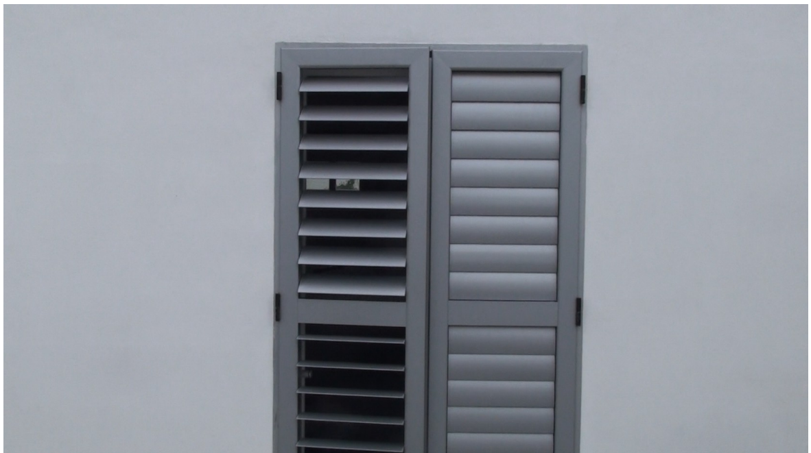
Ejemplo de distintos grados de apertura en una mallorquina de lama móvil
