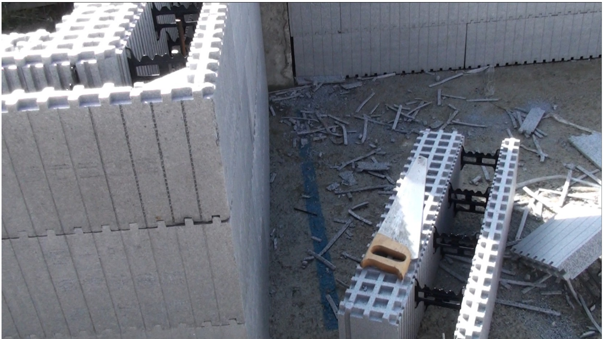
Jornada 1 – 19/04/2011 – Colocación de las primeras 4 hileras previas al aplomado
