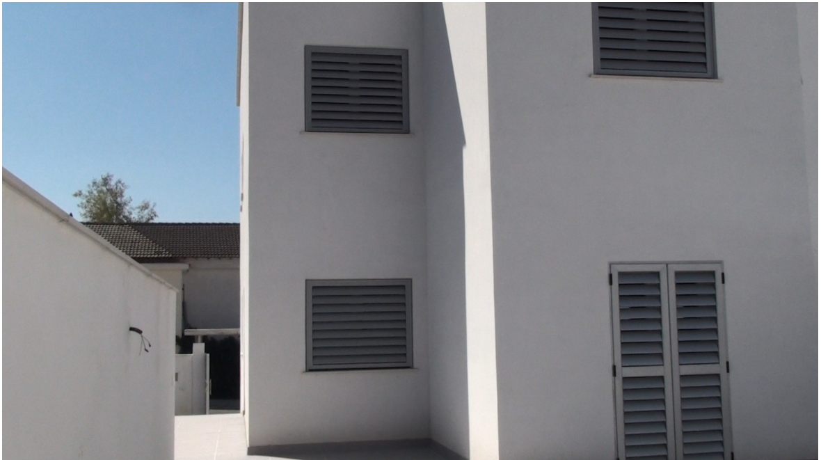
Detalle de fachada del patio trasero terminada con todos sus elementos
