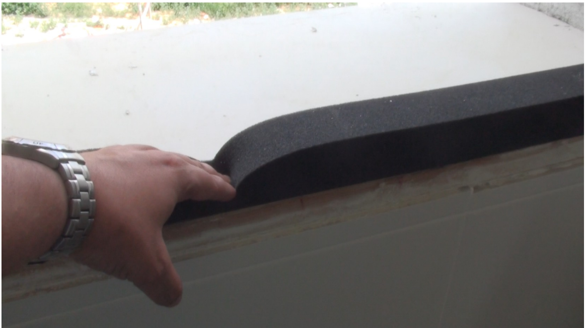
Detalle del material de apoyo en marco de ventana para el ajuste perfecto
