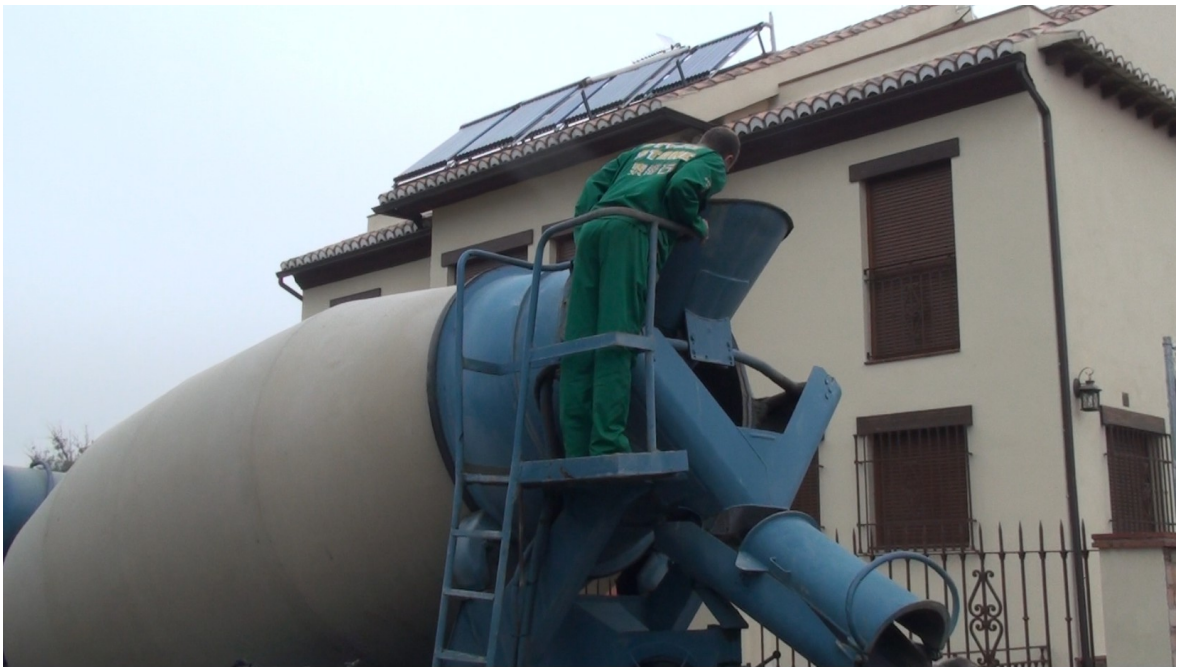
Jornada 3 – 25/04/2011 – Verificación de fluidez y granulación del hormigón por Styrostone
