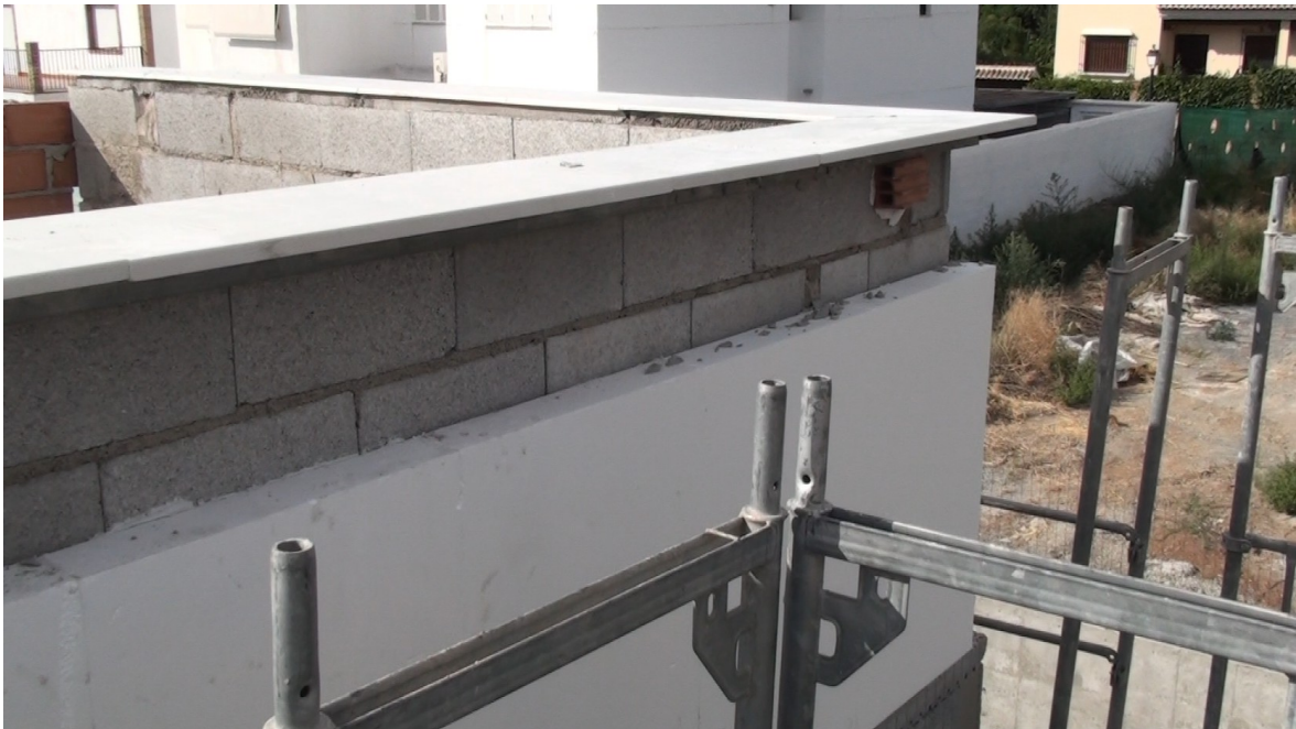
Planchas de EPS para mantener la continuidad de dilataciones
