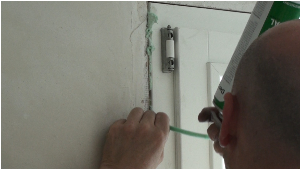
Inyección de espuma aislante de poliuretano en el sellado de juntas de ventana
