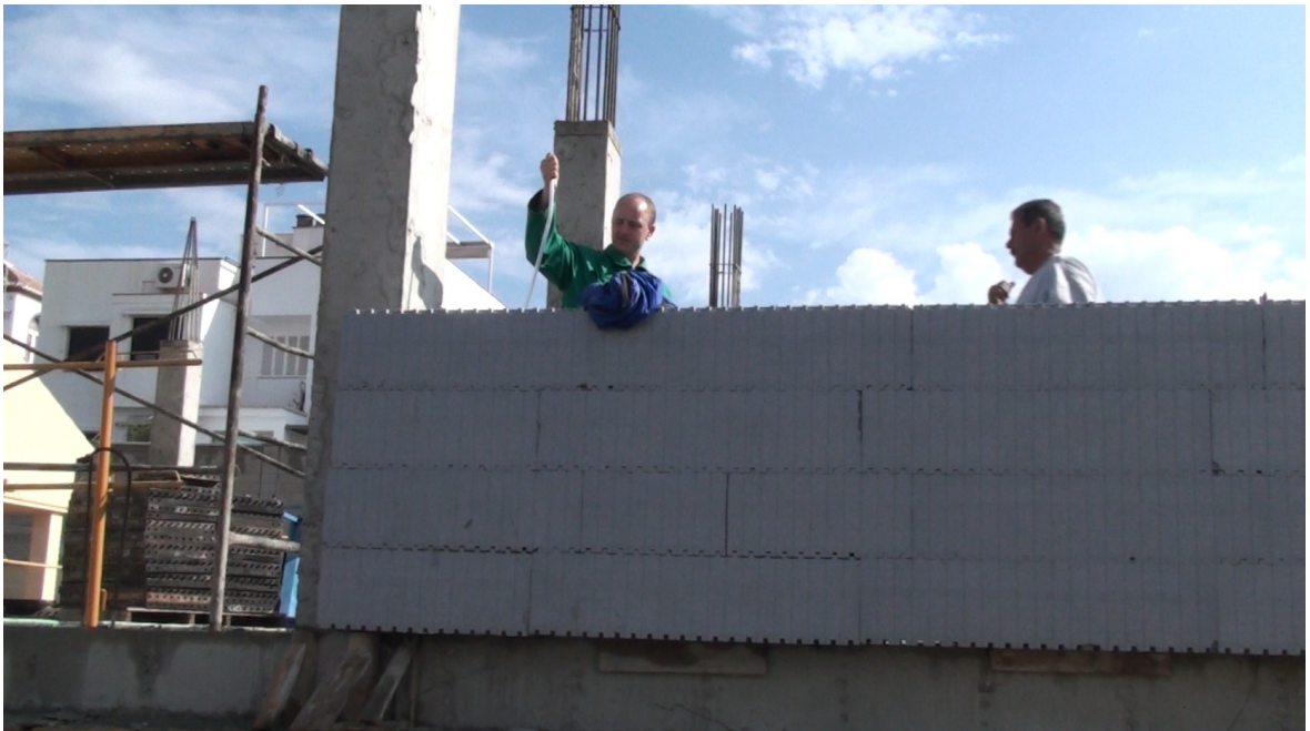
Jornada 1 – 19/04/2011 – Verificación de nivelación y aplomado del cerramiento
