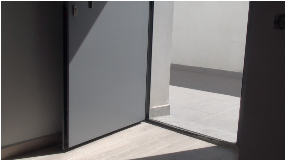
Puerta Hörman TermoPro modelo TPS 010 con transmitancia U=1,2W/m^2°C
