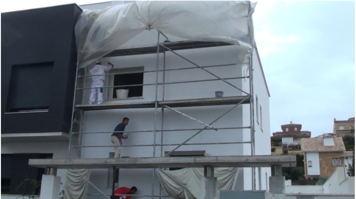
Trabajos de terminación de últimas capas de revestimiento en fachada
