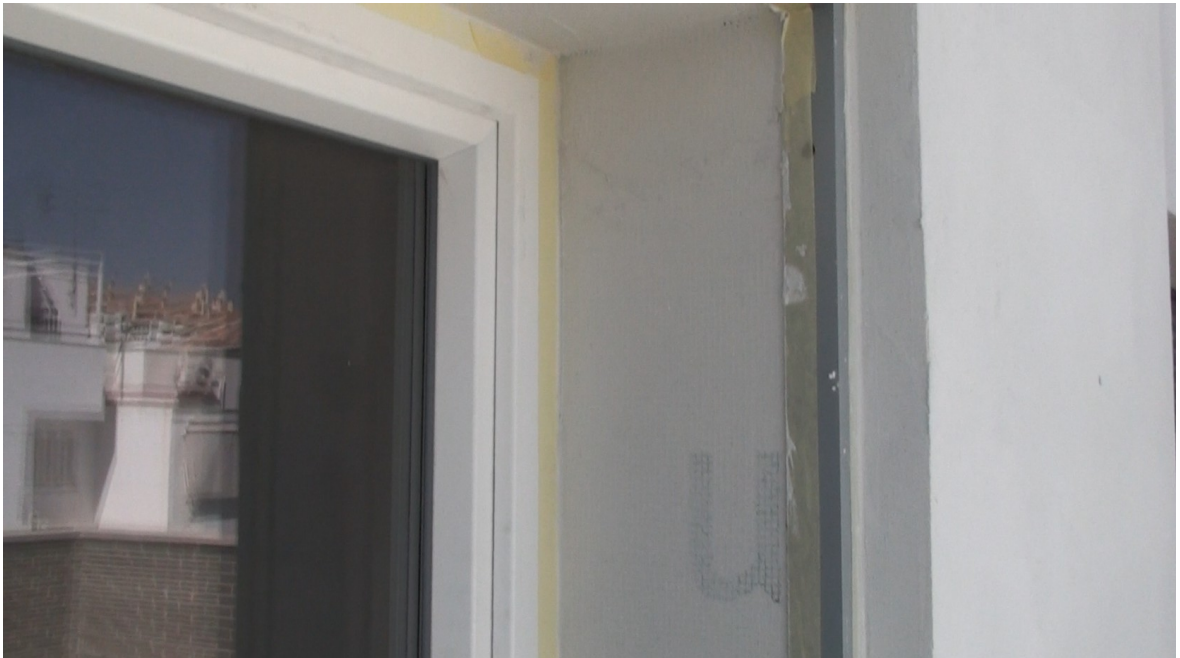
Ejemplo de plancha de aislamiento supletorio para cubrir parte del marco en jambas
