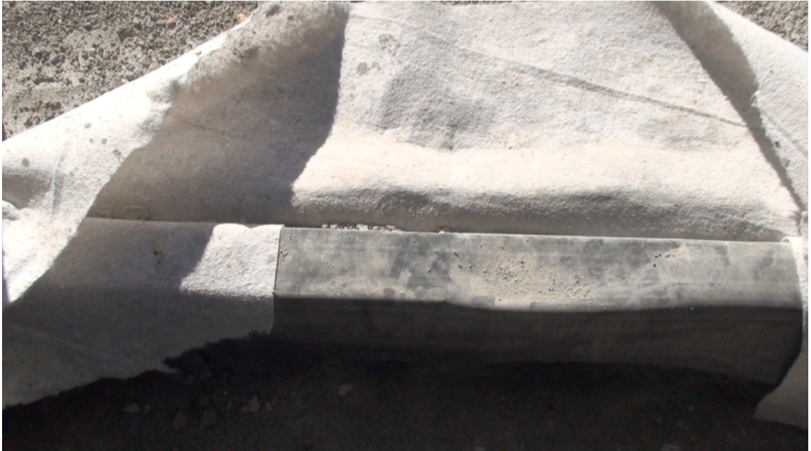
Lámina geotextil para proteger aislamiento e impermeabilización
