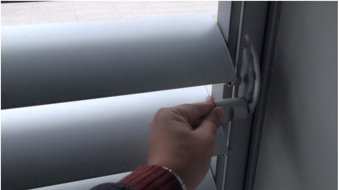
Ejemplo de regulación manual que permite inclinaciones inversas sobre la horizontal
