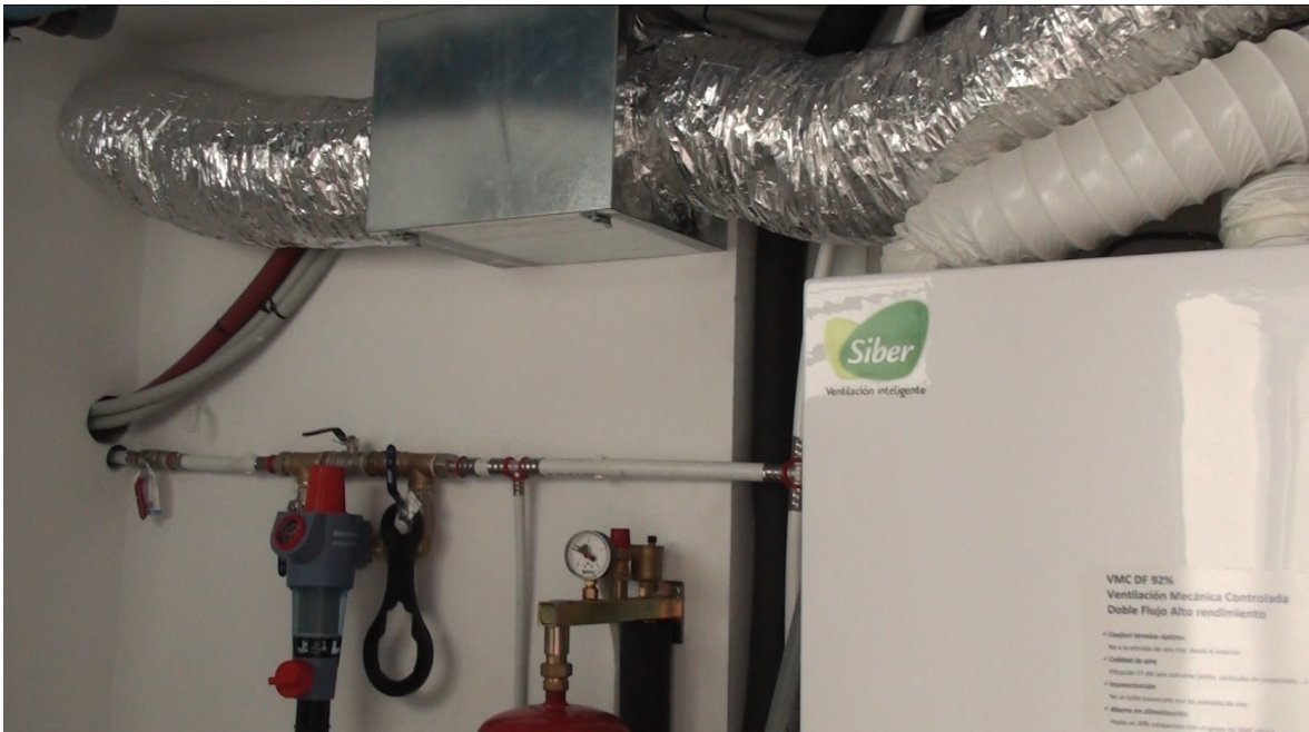
Acometida de agua con filtro Honeywell FK74CS para proteger la instalación de impurezas
