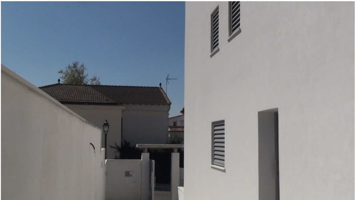
Detalle de fachada lateral de acceso peatonal a interior de vivienda
