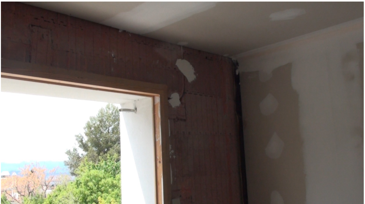
Tono rosaceo del aislamiento tras aplicar el puente de adherencia para el Yeso
