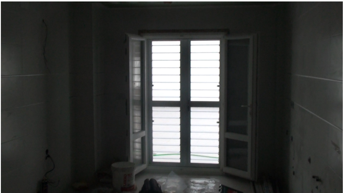
Ejemplo de paso de luz con el sistema de mallorquina en posición abierta y el resto cerradas
