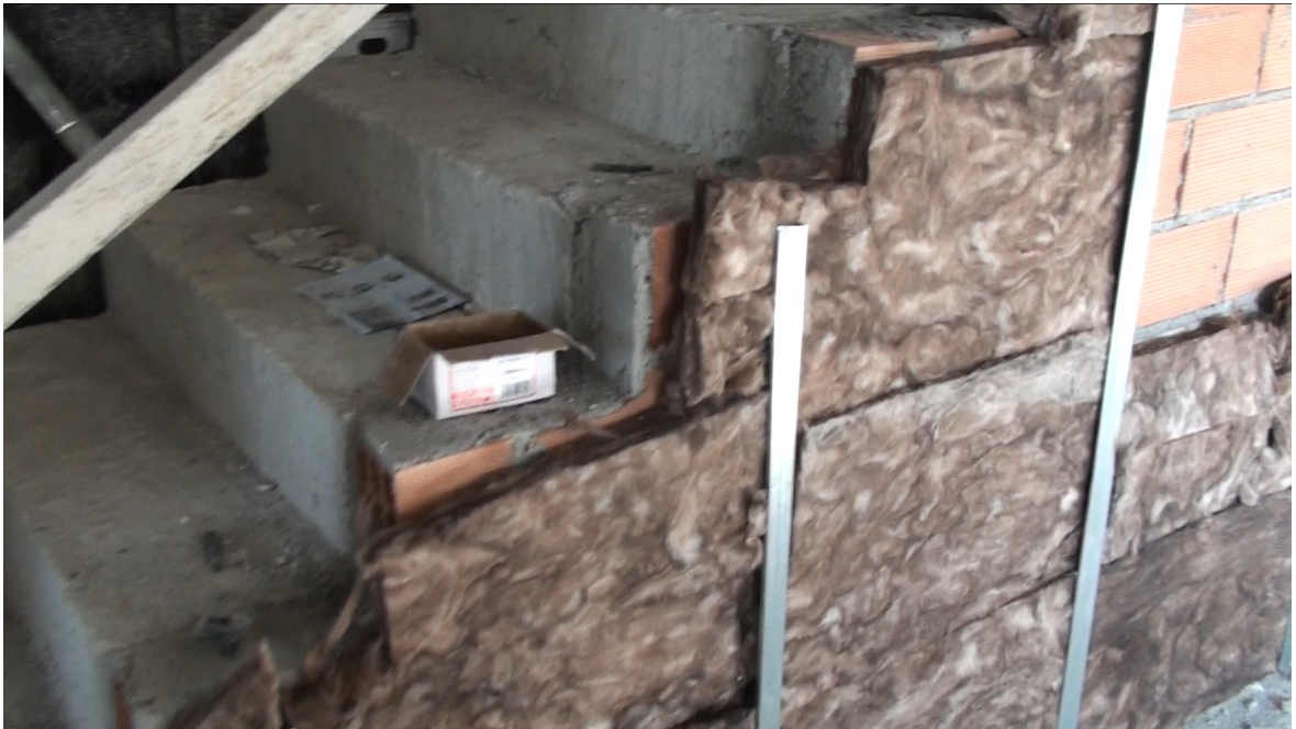
Aislamiento de lana de roca en toda la tabiquería de Pladur
