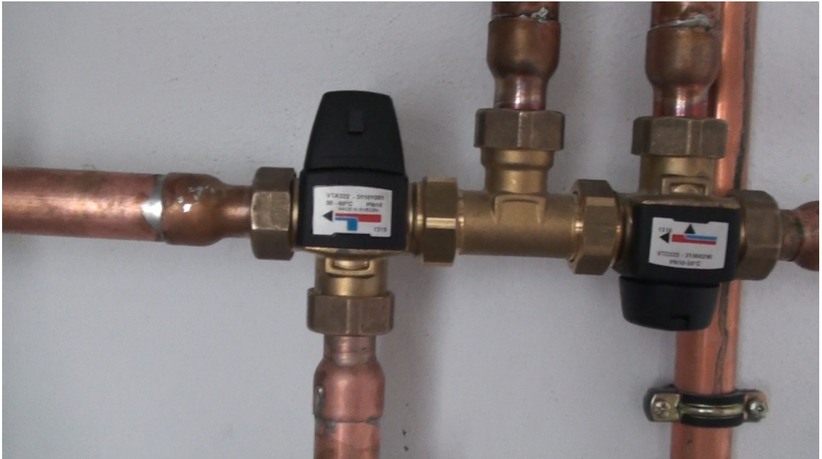
Valvulas termostaticas mezcladora y selectora, para el aprovechamiento solar, ESBE VMC322
