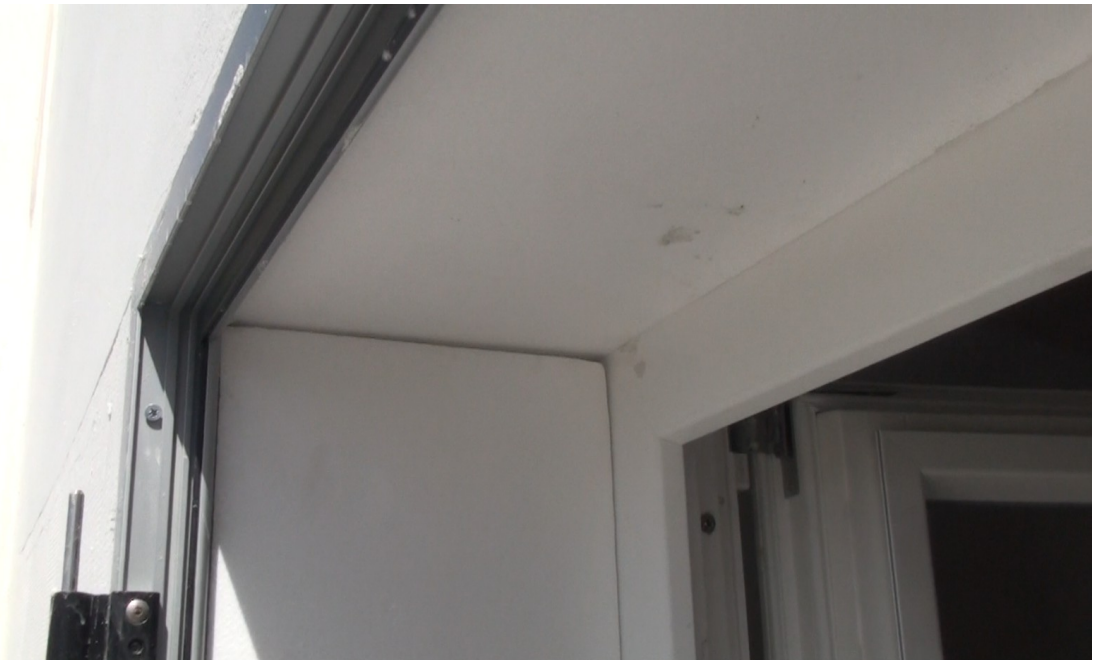
Ejemplo de plancha de aislamiento supletorio para cubrir parte del marco en dintel
