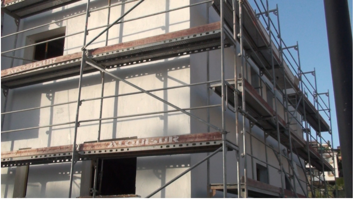
Primera mano del revestimiento para proteger el aislamiento de rayos ultravioleta
