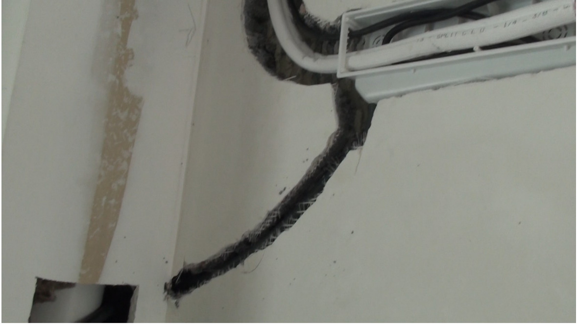
Detalle de la malla de fibra de vidrio aplicada al revestimiento de Yeso proyectado
