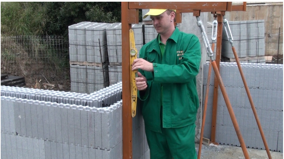
Jornada 1 – 19/04/2011 – Verificación del aplomado en reglas del andamiaje por Styrostone
