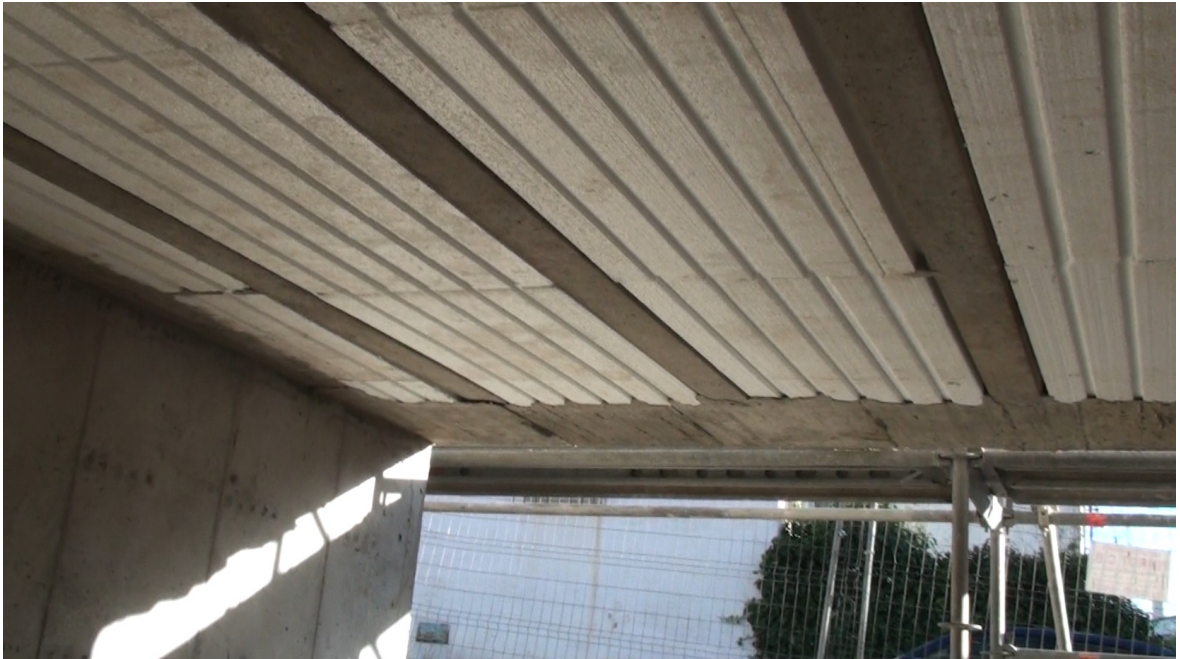
Bobedillas aislantes en suelos de planta baja (visto desde el techo del sótano)
