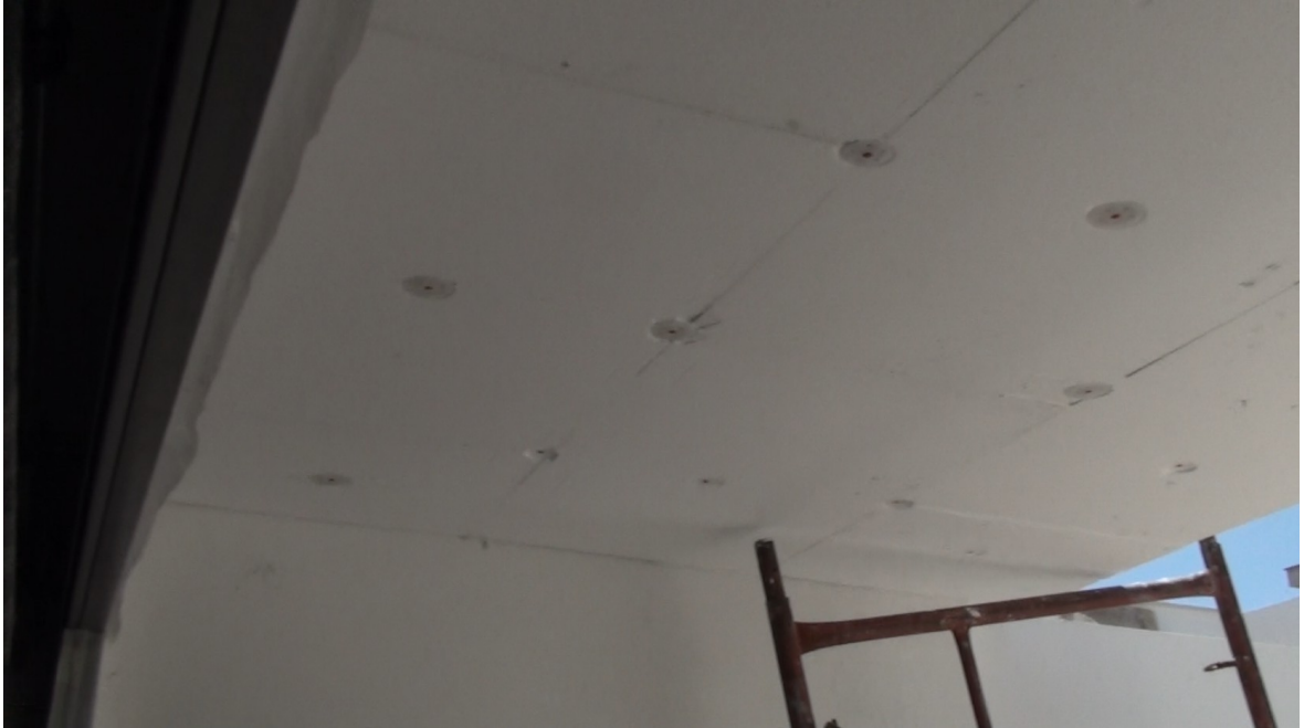
Planchas de aislamiento EPS de 5cm fijadas al techo del forjado de entrada al garaje
