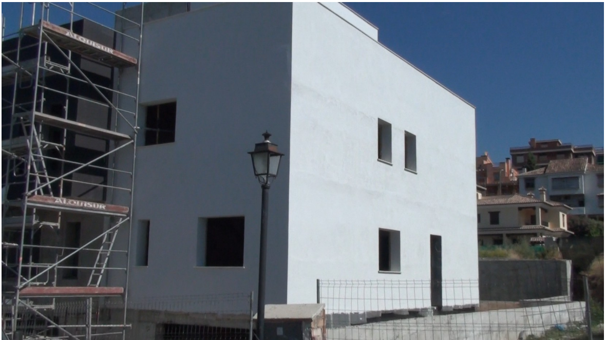
Aspecto de las primeras tres capas tras retirar el andamiaje
