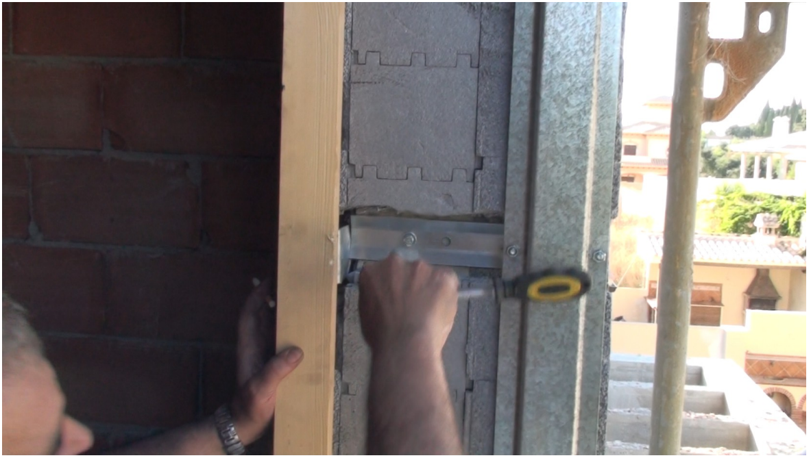
Fijación del premarco de Ventana y Celosías para el Sombreado de Huecos
