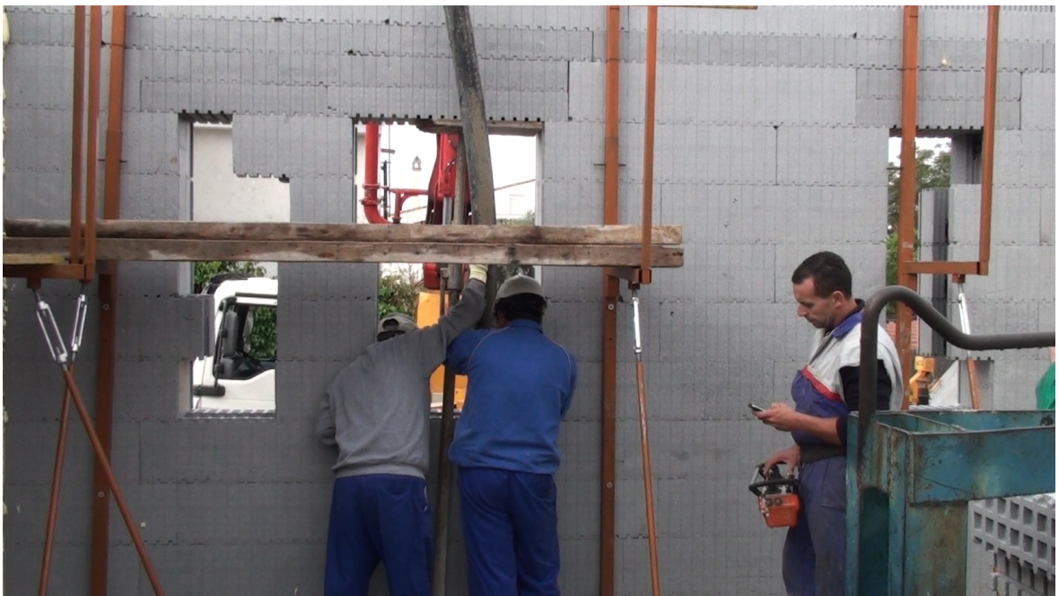
Jornada 3 – 25/04/2011 – Vertido de hormigón en zona baja, desde azféizar de ventanas
