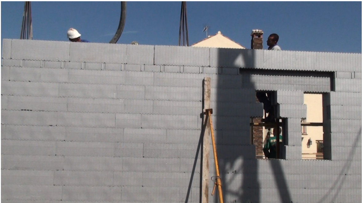
Jornada 3 – 25/04/2011 – Apuntalado junto a zona de pilares
