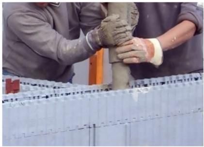
Por favor, tenga en cuenta que la tubería de goma de la bomba de hormigón debe ser de 700mm de diámetro; es posible realizar el trabajo con tubería de 100mm, provocando dificultades la de 125mm.
